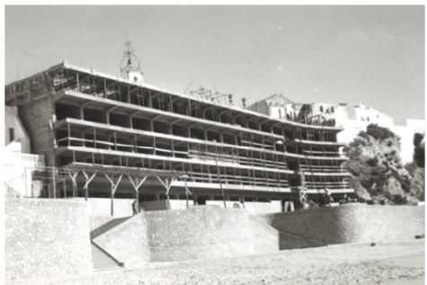
Imagem 23 – Construção do Hotel Sol e Mar, junto à praia
