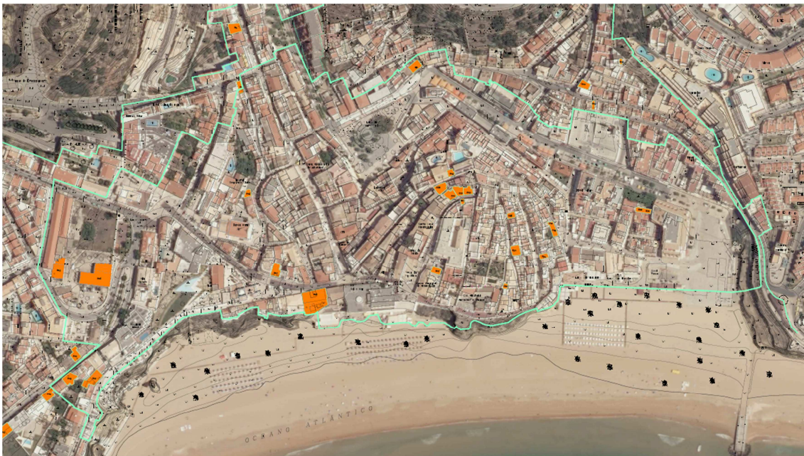
Imagem 43 – Levantamento de edifícios em ruína no centro antigo de Albufeira (GRUA, julho de 2016)
