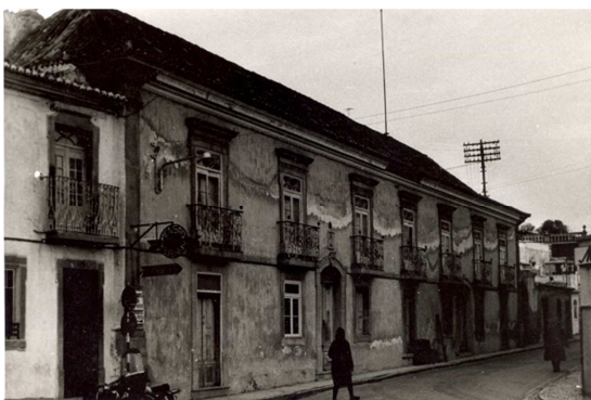
Imagem 20 – Edifício na Rua 5 de outubro (n.º 61 a 67), década de 60
