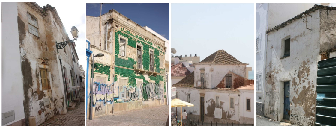
Imagem 42 – Edifícios em ruína ou devolutos na zona a delimitar pela ARU do Centro antigo de Albufeira
