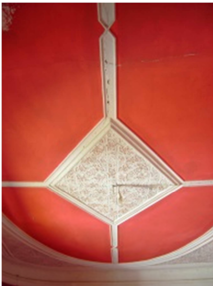
Imagem 18 – Estuque no interior do edifício
