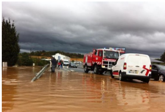
Figura 5.12-2 - Inundações na depressão existente junto à EN395, com constrangimentos na via
