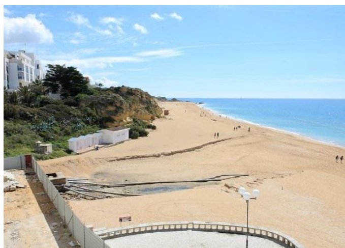
Figura 5.9-2 - Erosão do areal a jusante da descarga, na praia do INATEL
