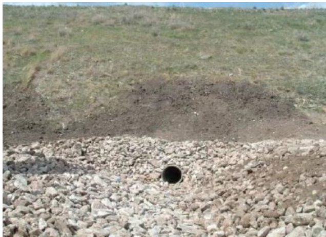
Figura 5.9-4 - Tapete de enrocamento à saída de uma passagem hidráulica
