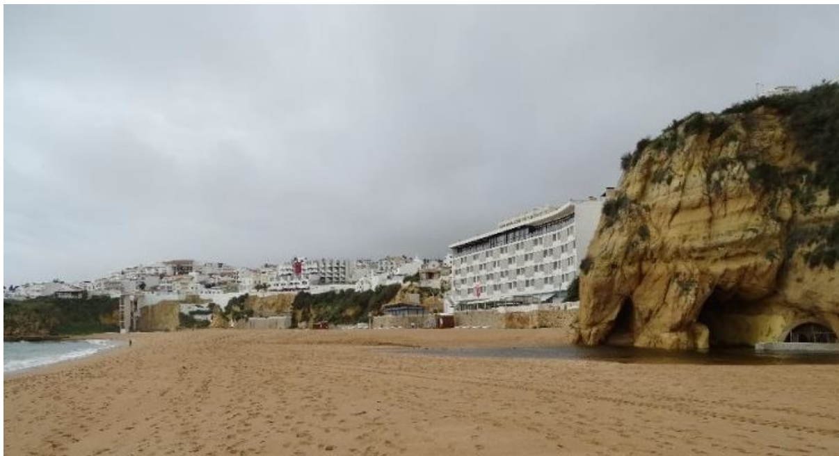
Figura 5.9-3 - Formação de uma bacia de retenção devido à recarga natural do areal na zona de descarga do túnel na praia dos Pescadores Fonte: (Hidra, 2016b)
