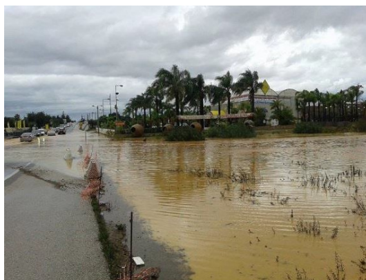
Figura 5.12-1 - Inundações no atravessamento da EN125 com a ribeira de Ataboeira (01/11/2015)
