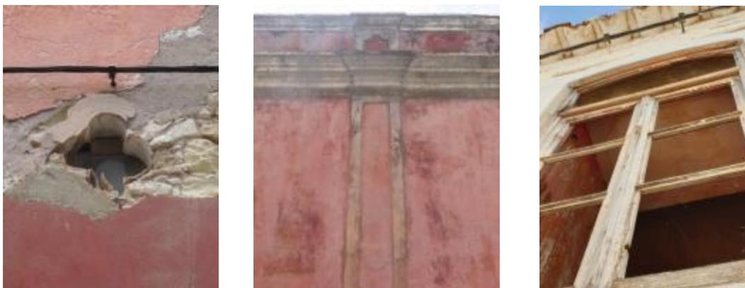
Figura 32. Exemplos de revestimentos existentes em edifícios na aldeia de Paderne – óculo, pilastra e teto interior junto ao vão
