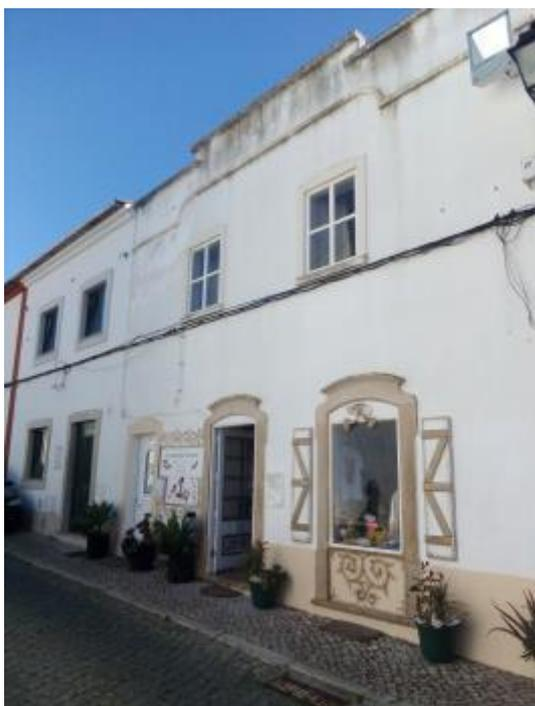
Figura 52. Exemplo de edifícios com cabos elétricos expostos nas fachadas
